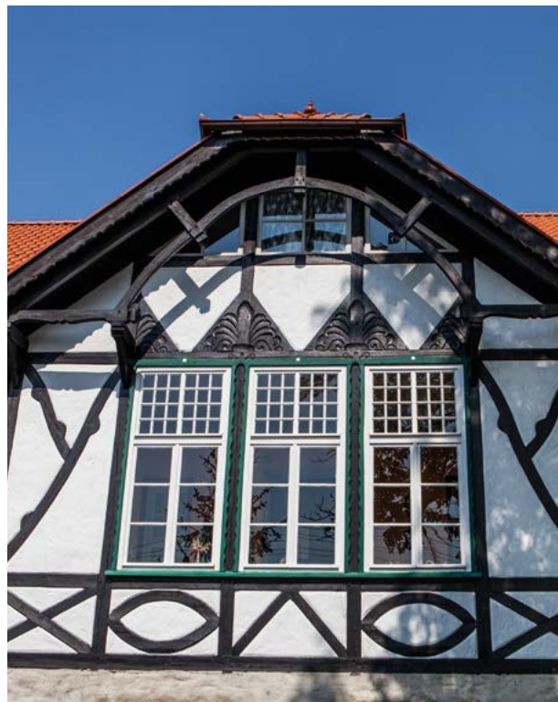
Ciekawa architektura w Bysławku
